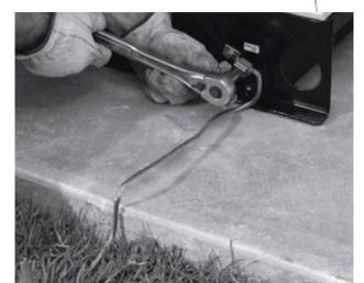
Coloque una jabalina o línea a tierra de sección adecuada y aprobada para el terminal de conexión a tierra en la base inferior del generador.
