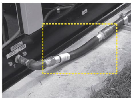
Es obligatorio la instalación del caño flexible provisto con el equipo para absorber las vibraciones y proteger la instalación de gas.
